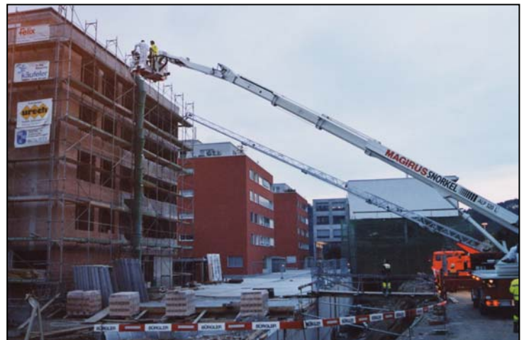
Einsatz Baustelle Etzel matt: Vorne Hubretter, hinten ADL 72
